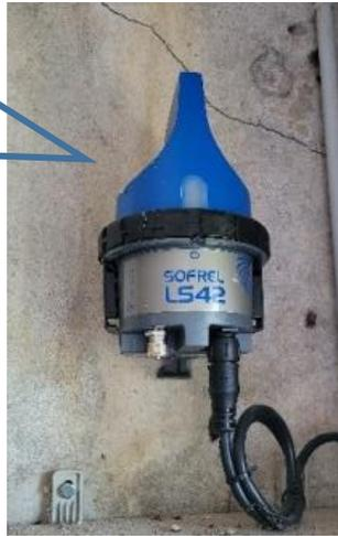
Compteur équipé d'un capteur intelligent relié au boîtier de télérelève
