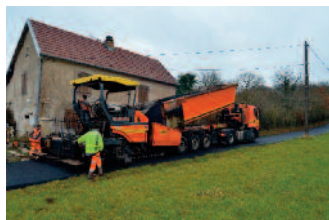
Pose d'enrobé à Brevoines
